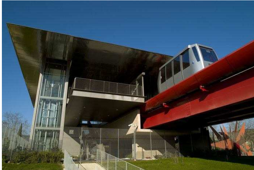
Stazione del MiniMetrò di Perugia
